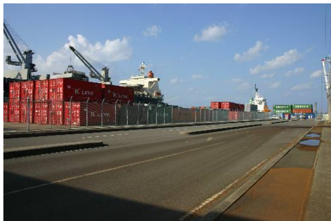
【コンテナヤード】
