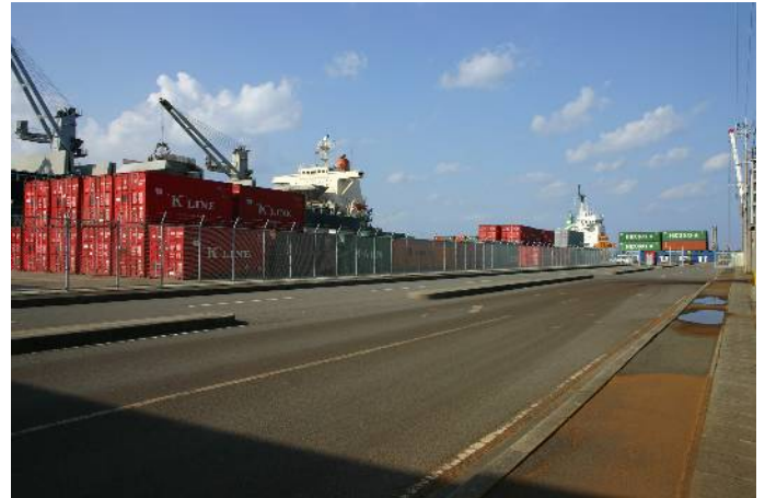
【コンテナヤード】
