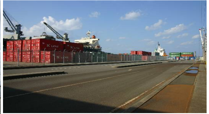
【コンテナヤード】
