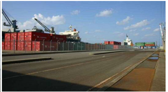
【コンテナヤード】
