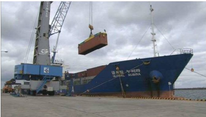
【コンテナ船と移動式ハーバークレーン】
