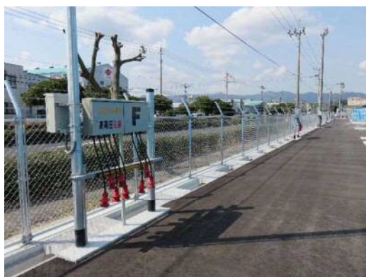
【48本常設したリーファーコンテナプラグ】
