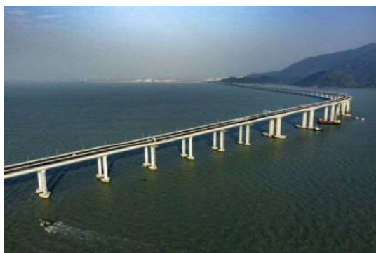
港珠澳大橋（香港特別行政区路政署ホームページより抜粋）
