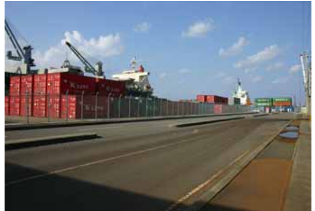
【コンテナヤード】
