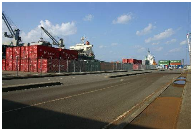
【コンテナヤード】
