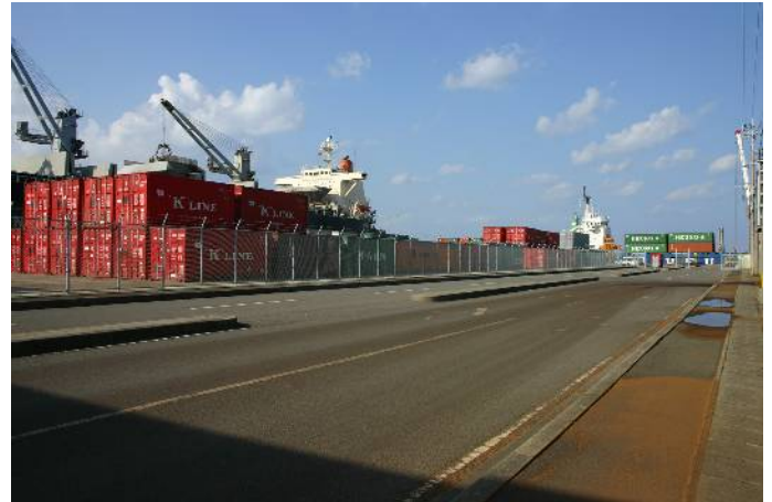
【コンテナヤード】
