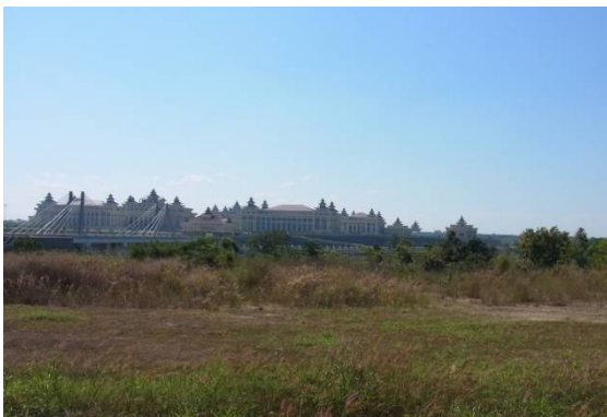
敷地外から見る国会議事堂。
