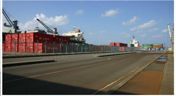
【コンテナヤード】
