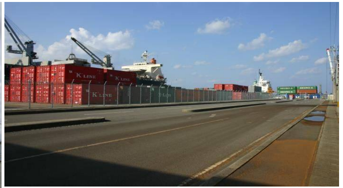
【コンテナヤード】
