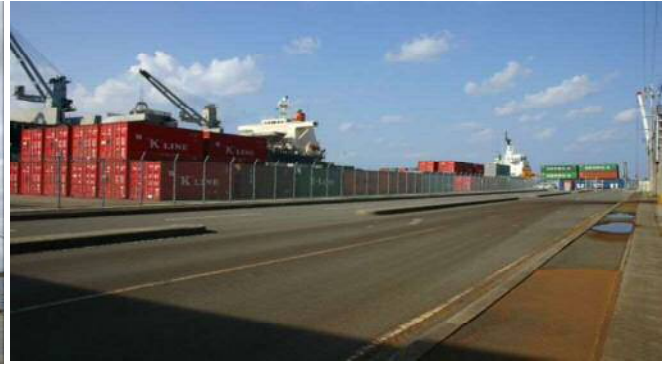
【コンテナヤード】
