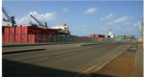
【コンテナヤード】
