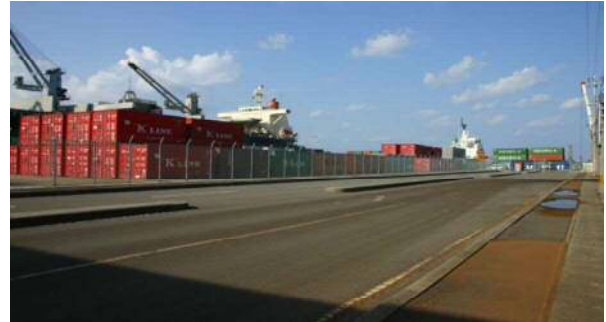
【コンテナヤード】
