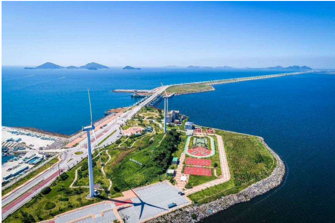
セマングム防潮堤
